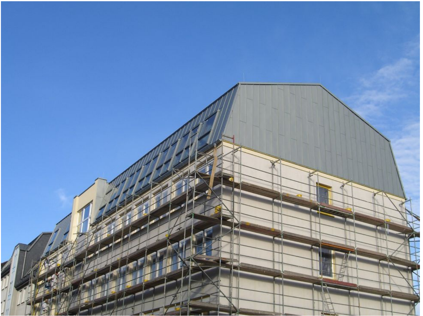
— Dacheindeckung und Fassadenverkleidung Rheinzink vorbewittert-blaugrau
