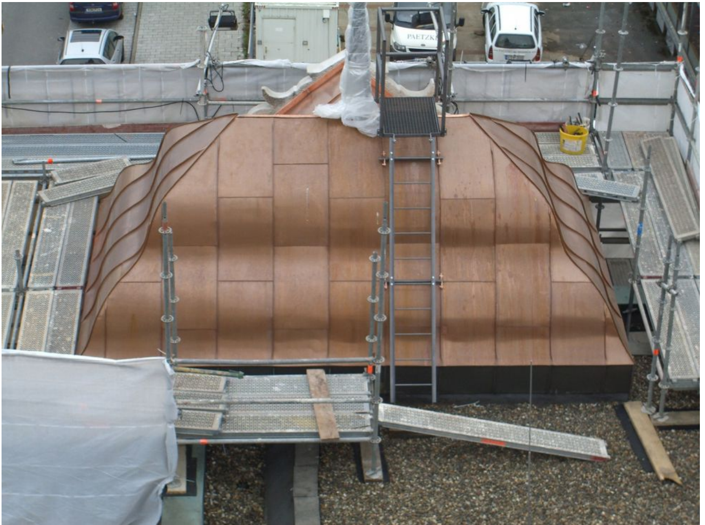
_ Dachsanierung in Kupfer
